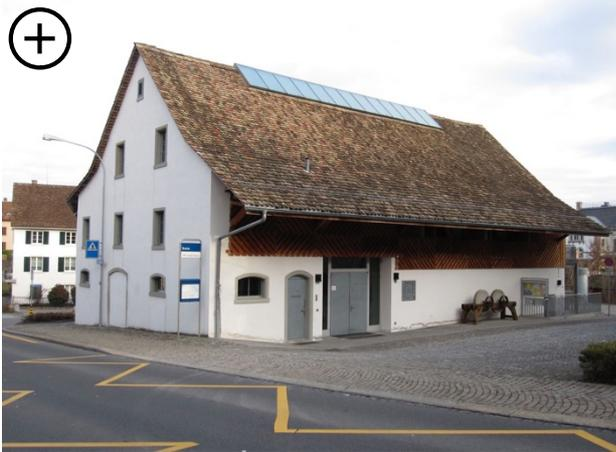
Grossflächige Lösungen erhalten den ruhigen Gesamteindruck. Durch den Verzicht auf Dachaufbauten bleibt die zusammenhängende Dachfläche erhalten
