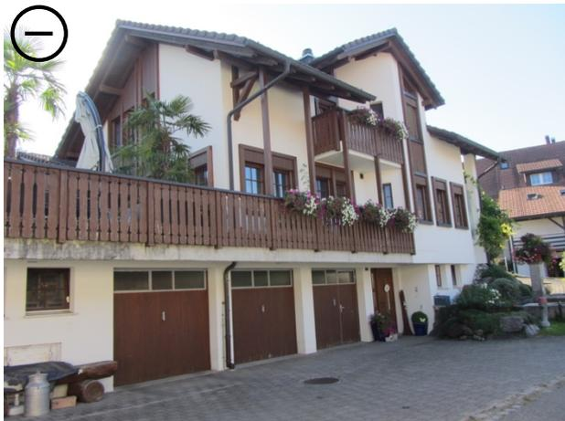
Der Dachaufbau unterbricht die Traufe: Fassade und Dach sind nicht getrennt.
