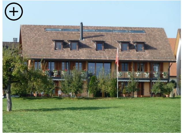
Dachaufbauten müssen zur Formensprache des Hauses passen: Kleinteilige Dachaufbauten, die sich dem Hauptbau unterordnen.
