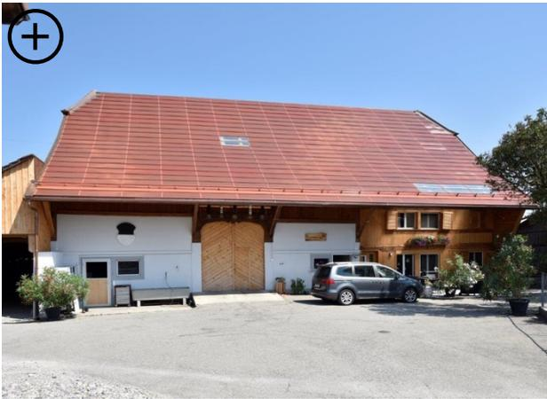
Ziegelrote Solarmodule integrieren sich besser in Dachlandschaft von hellen Ziegeldächern.
