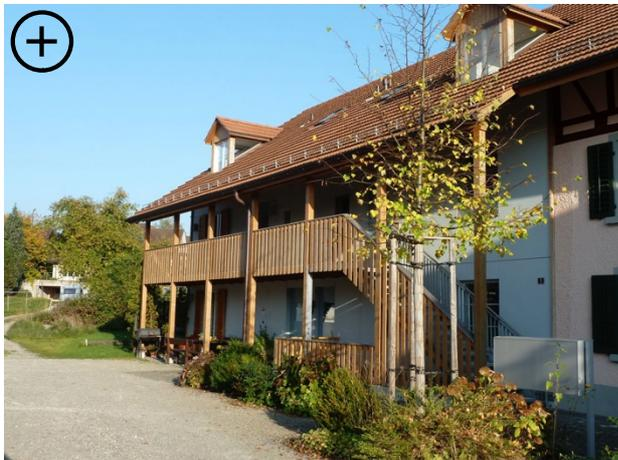
Abgestützte Balkonkonstruktion in Holz
