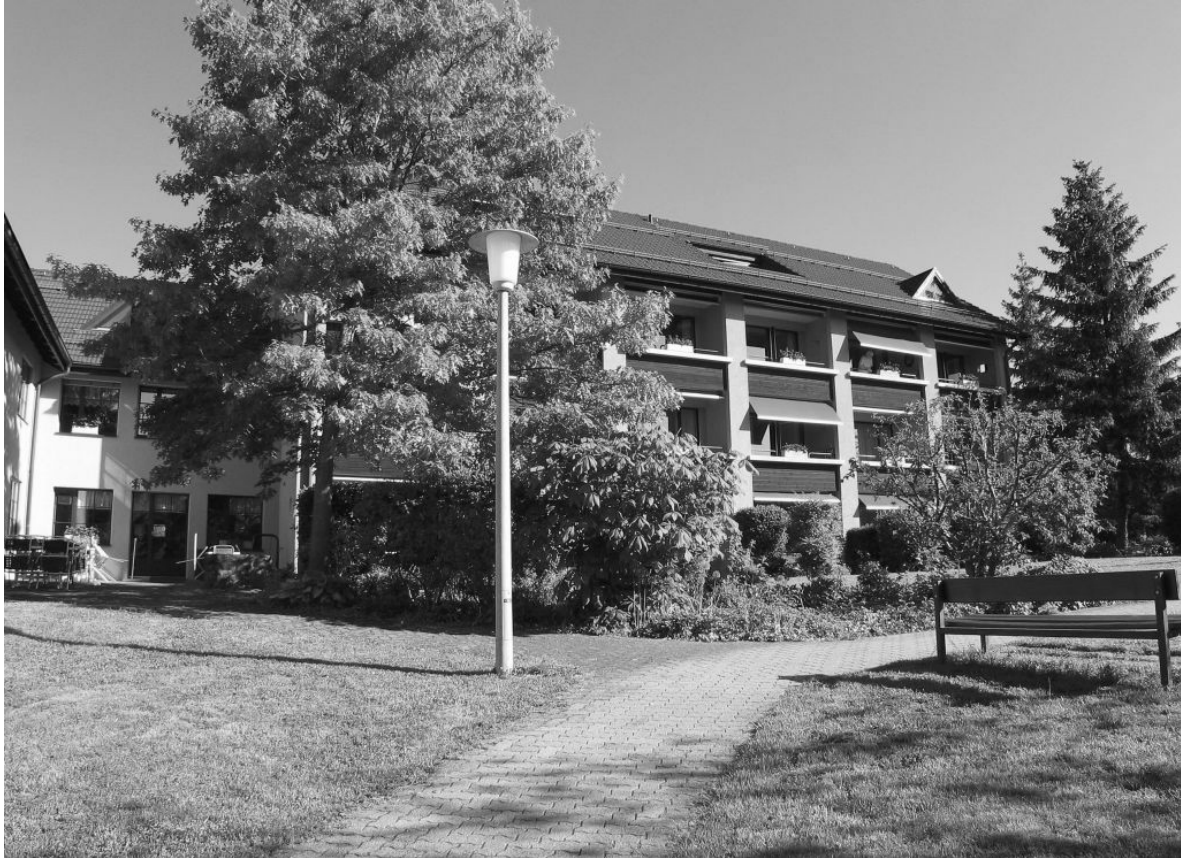
Abbildung 1: Alters- und Pflegezentrum an der Rosengasse
